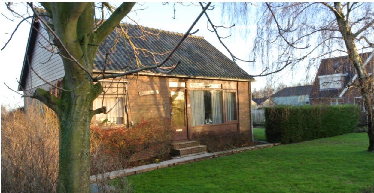
Aanzicht bestaande woning
