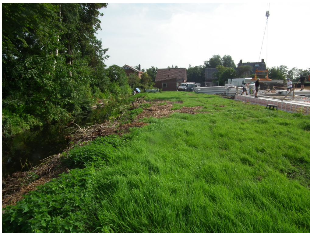
Figuur 1 De planlocatie is gelegen aan Noordeinde 88 te Leimuiden, aan de grens van het dorp Leimuiden. De beoogde ruimtelijke ontwikkeling bestaat uit de realisatie van nieuwe woning
