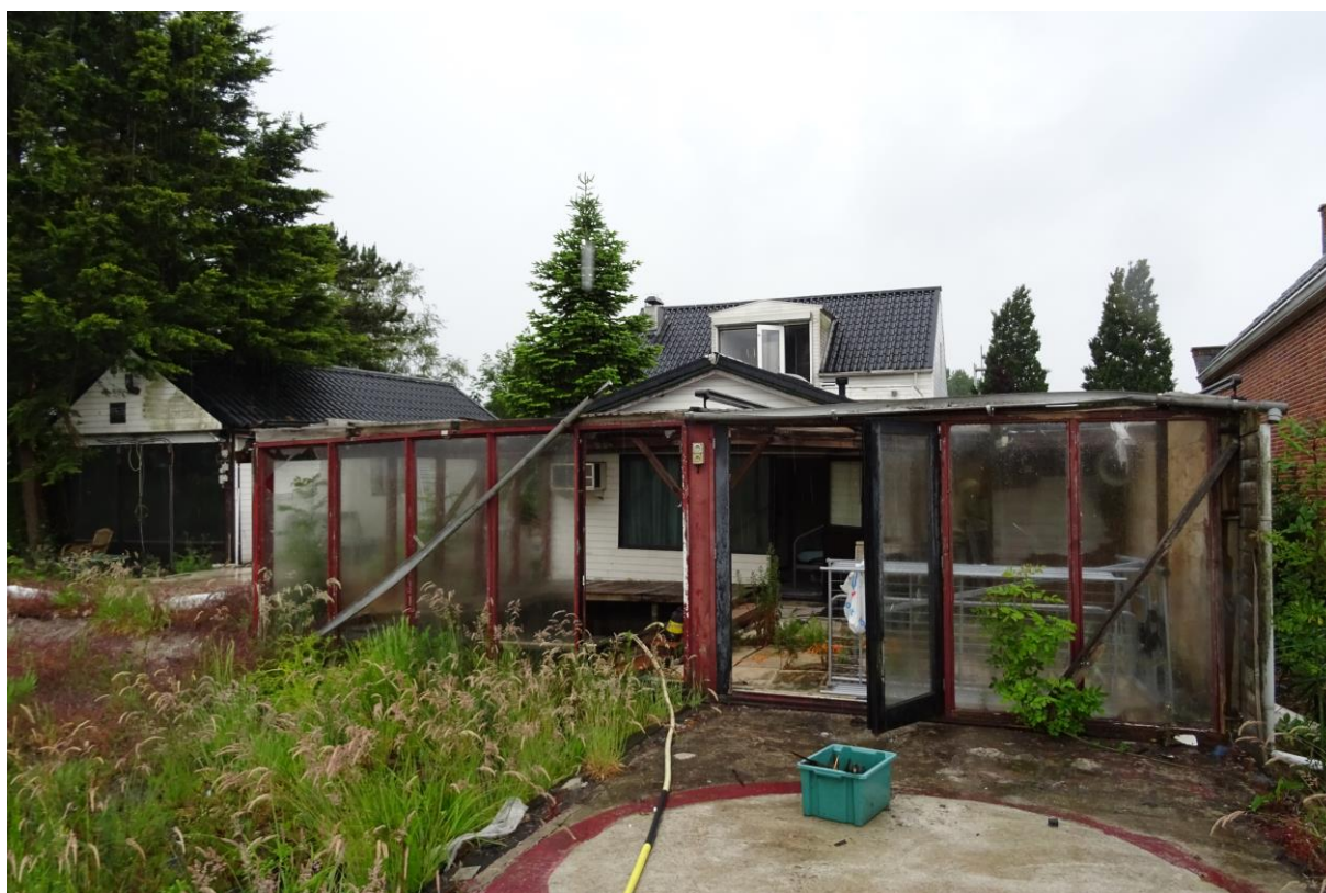
Afbeelding 12: het tuinhuis/ serre welke gecontroleerd is op de aanwezigheid van vleermuizen/ mogelijke verblijfplaatsen van vleermuizen. Bron: R.J.L. Bijvelds 05-06-2020
