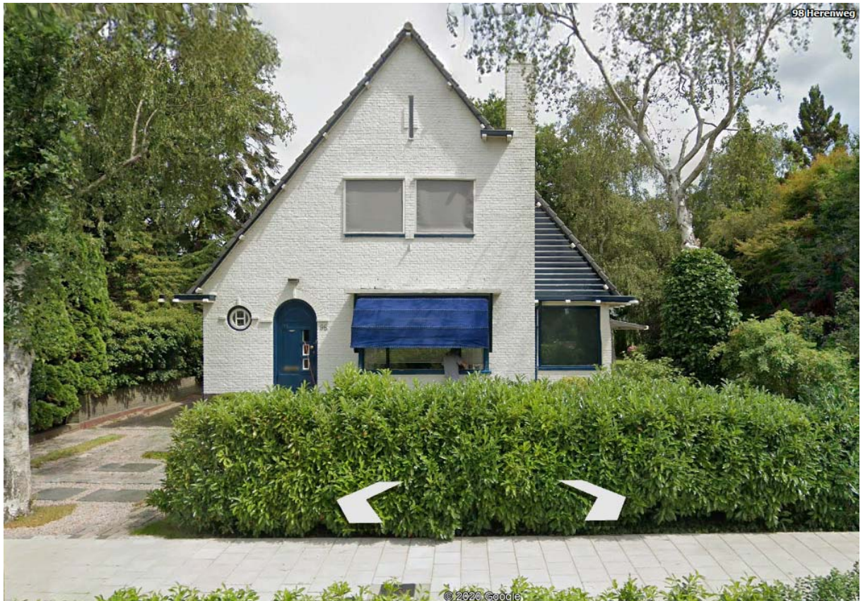
Rechts de bestaande woning Herenweg 68
