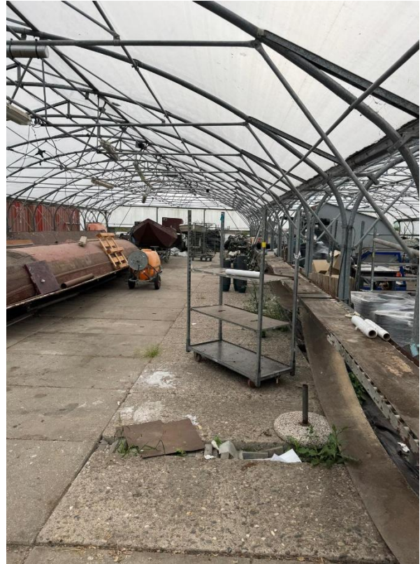
Figuur 6: het interieur van een van de kassen. De spanten zijn van gegalvaniseerd ijzer.
