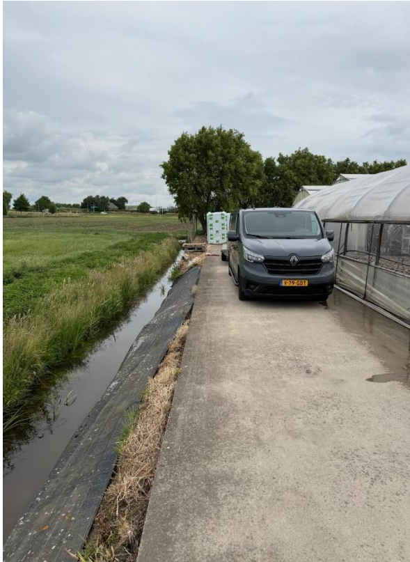
Figuur 5: Het betonnen kavelpad en detail van de slootkant, deze is afgedekt met worteldoek
