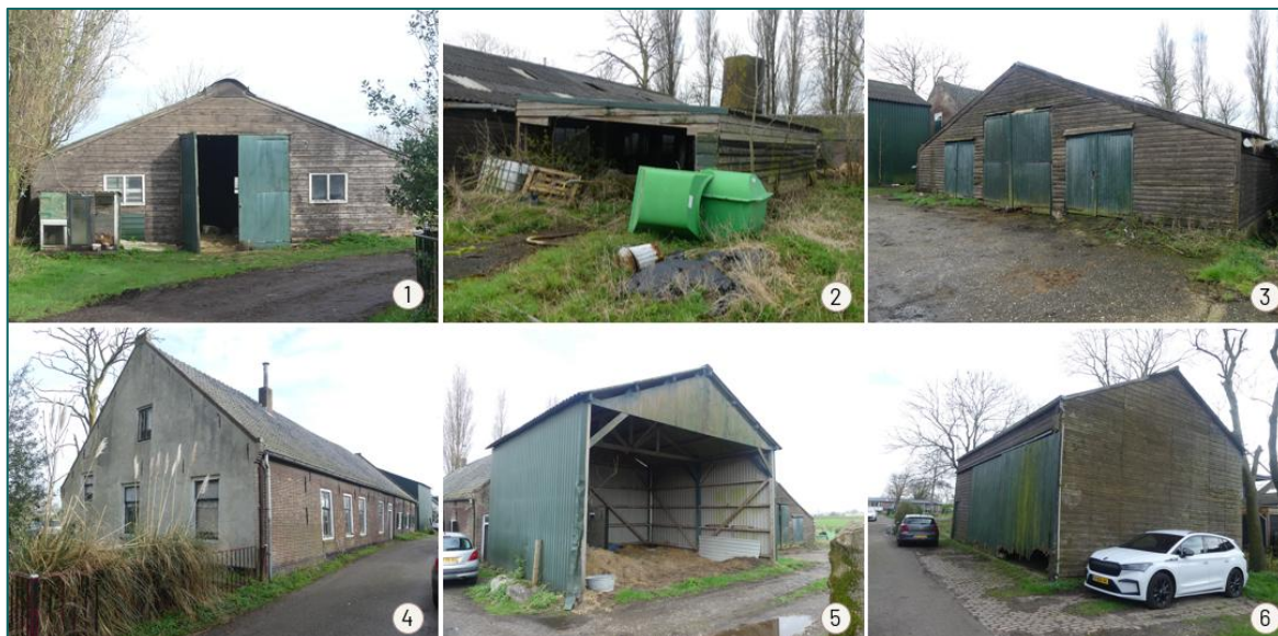
Figuur 1.3 Een impressie van de te slopen bebouwing. De nummering in de figuur komt overeen met figuur 1.2.
