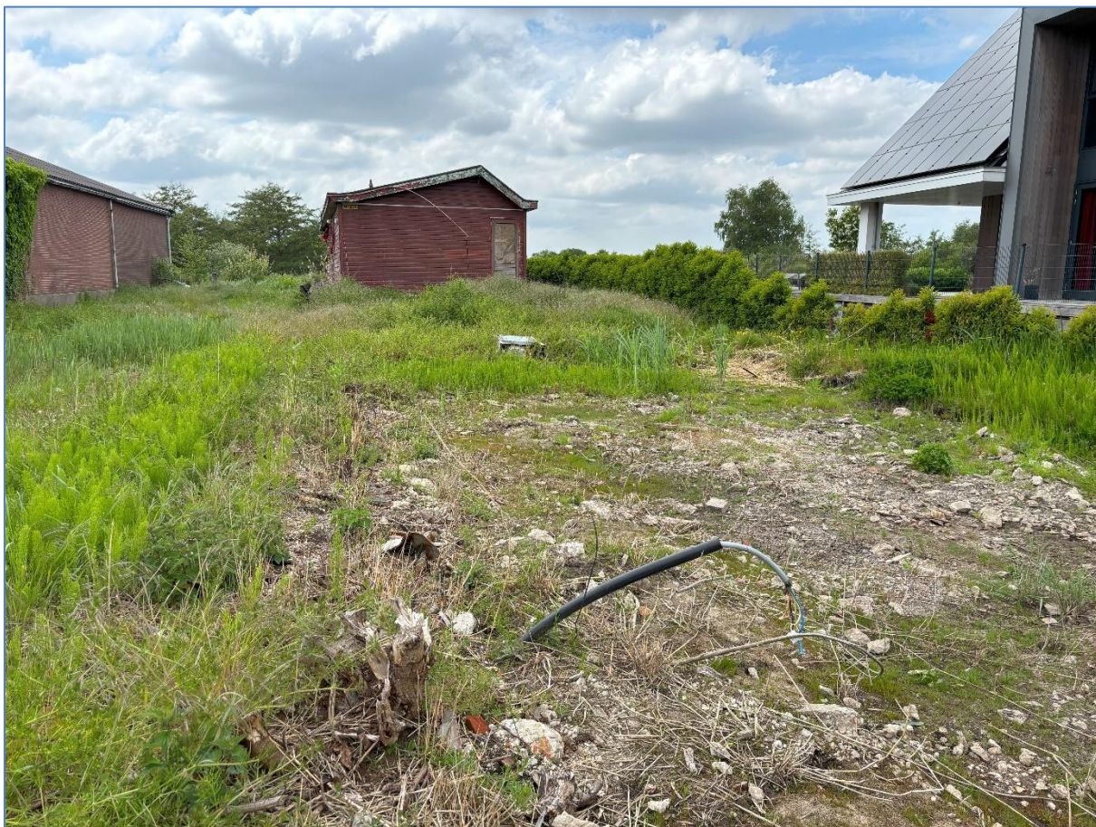
Afbeelding 3: kabels en leidingen komen uit de grond omhoog op de locatie van de oude bebouwing.
