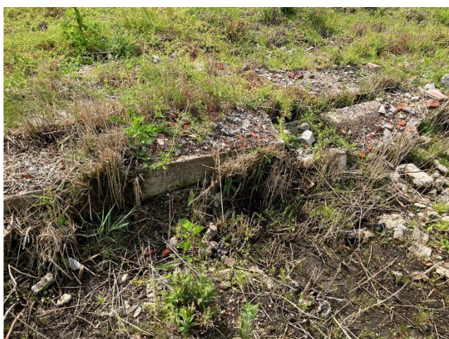
Foto 9 – puin op maaiveld
