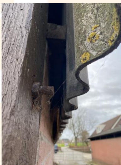
3.d Aansluiting golfplaten
