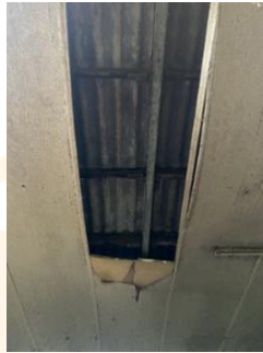
3.b loshangende isolatie
