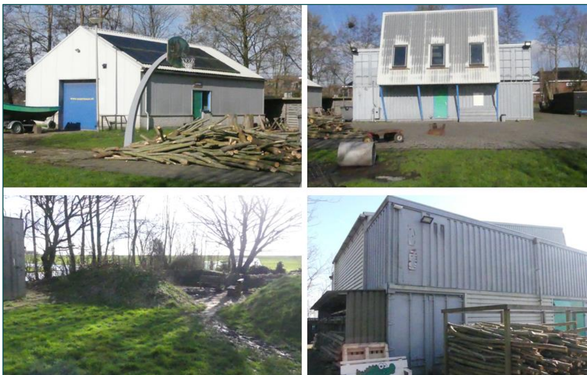
Figuur 1.2 De scoutingvereniging op perceel 1 aan de Kerklaan te Leimuiden. Er zijn enkele clubgebouwen gesitueerd die zijn opgebouwd uit vrachtcontainers en sandwichpanelen. Rondom het scoutingterrein zijn bomen gesitueerd. De bebouwing wordt gesloopt en de bomen worden gekapt in de beoogde ontwikkeling.
