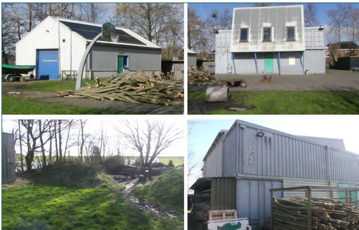
Figuur 1.3 De scoutingvereniging op perceel 1 aan de Kerklaan te Leimuiden. Er zijn enkele clubgebouwen gesitueerd die zijn opgebouwd uit vrachtcontainers en sandwichpanelen. Rondom het scoutingterrein zijn bomen gesitueerd. De bebouwing wordt gesloopt en de bomen worden gekapt in de beoogde ontwikkeling.
