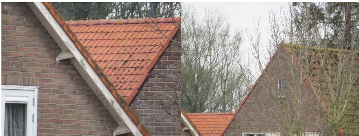
Afbeelding 10: Close-up foto's gevel, dakvlak en aansluitingen pannen op gevel.
