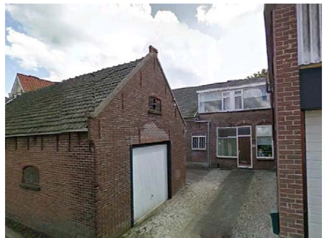
Bestaande situatie Raadhuislaan 15
