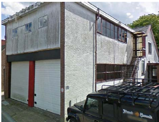
Bestaande situatie Raadhuislaan 11-13
