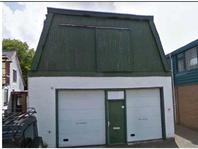
Bestaande situatie Raadhuislaan 7
