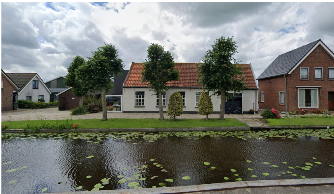
Afbeelding 2 Impressie plangebied, met de te slopen bebouwing met witte muren en rode dak. Bron: Google Streetview.
