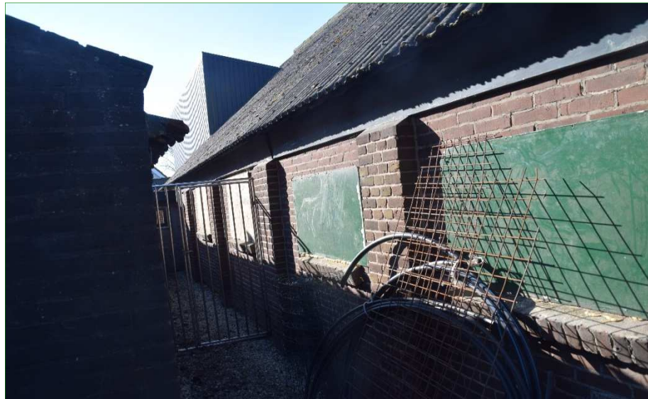
Gebouw 1: Oude stal in gebruik als schuur.
