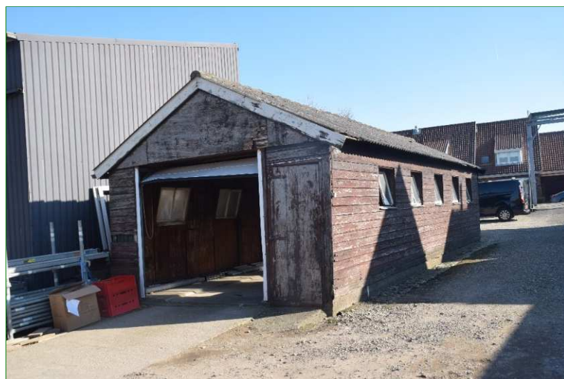
Gebouw 3: oude stal met garagedeur. Linksachter is de metalen schuur zichtbaar.
