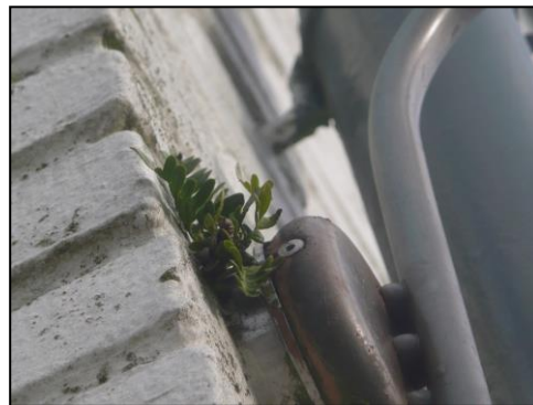
Eikvaren (foto: Laneco)
