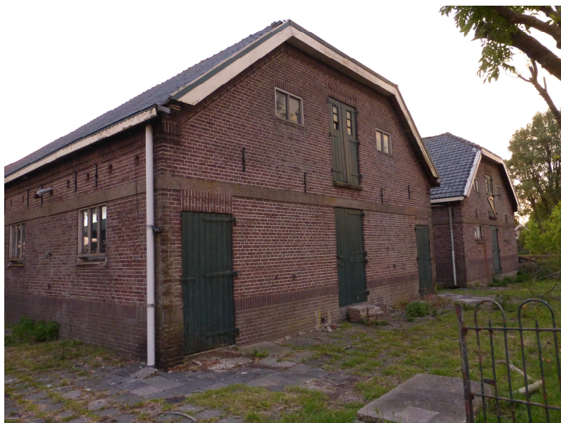
Figuur 4. Houten betimmering langs de dakrand.
