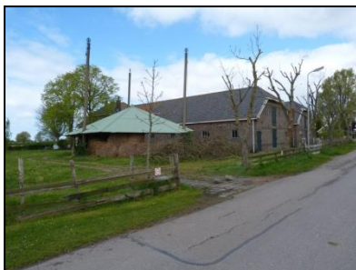
Figuur 3. Opstallen vanaf straatzijde
