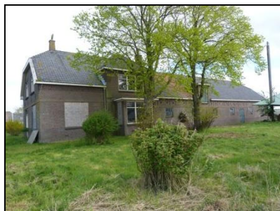
Figuur 4. Linkerdeel betreft voormalige woning.
