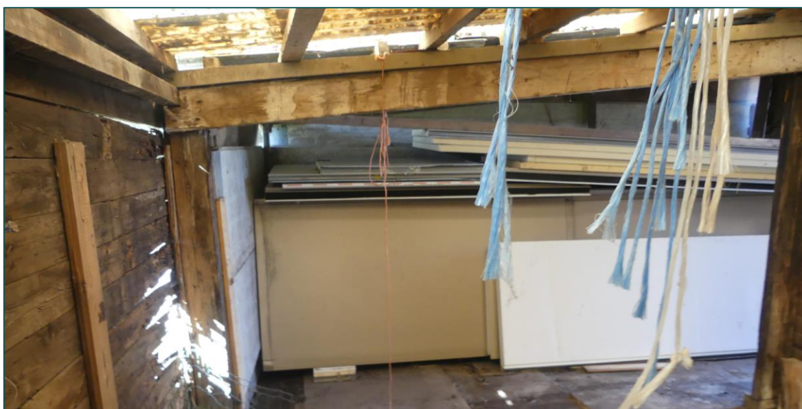
Figuur 3.1 De te slopen schuren hebben muren van houten planken en een golfplaten dak zonder dakbeschot, waar geen wegkruipplekken voor vleermuizen voorhanden zijn.
