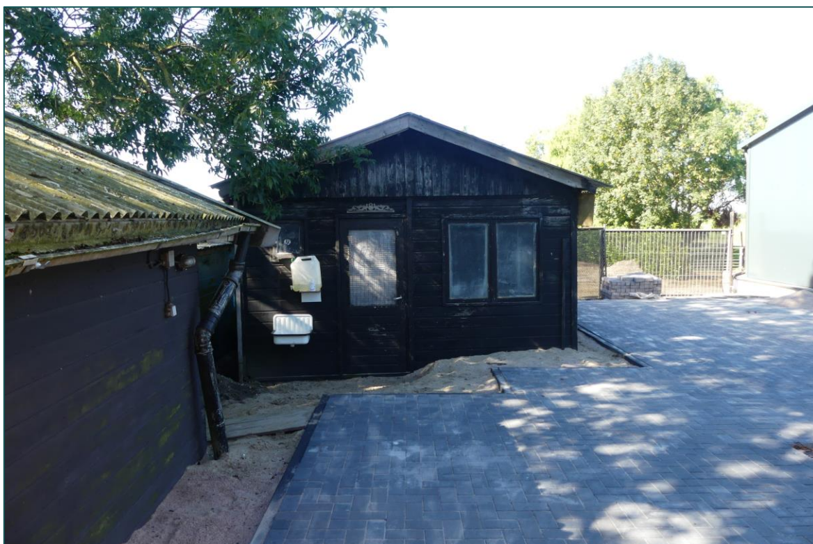
Figuur 2 Twee van de te slopen schuren (3 en 4).
