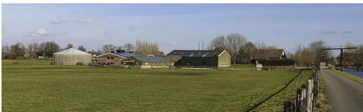
illustratie 3-3 Zicht op het bebouwingscluster Zwarteweg 8 vanuit het westen. (beeld: ir. wim klaassen - ARCHITECT)
