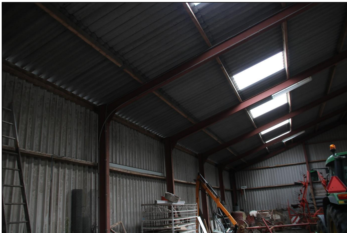
Figuur 8 Binnen constructie van de schuur waar permanente verblijfplaatsen gecreëerd zullen worden.
