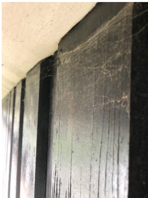
Aansluiting van gevelbetimmering op de dakoverstek. Er zijn geen mogelijkheden voor vleermuizen aangetroffen.
