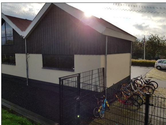
Figuur 6. Achterkant van het gebouw gezien vanaf noordwesten
