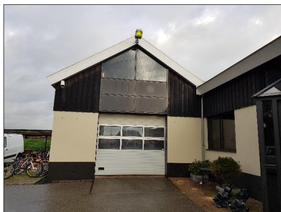
Figuur 7. Voorkant gebouw waar uitgebreid gaat worden gezien vanaf het zuidwesten
