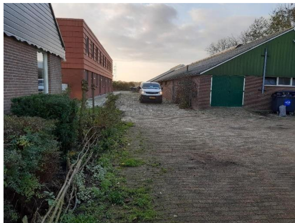
Foto 2: Voorterrein met ligboxstallen (rechts), bedrijfswoning (voor links) en logiesbedrijven (achter links)
