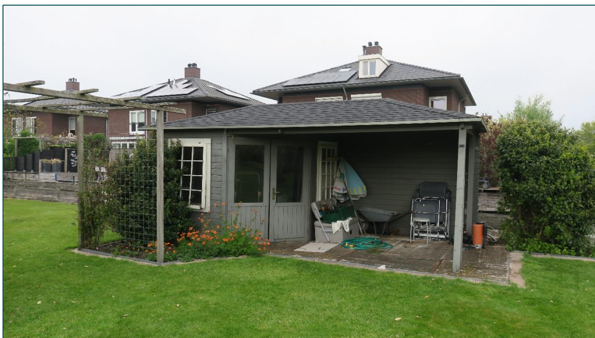
Figuur 2 De te slopen schuur.
