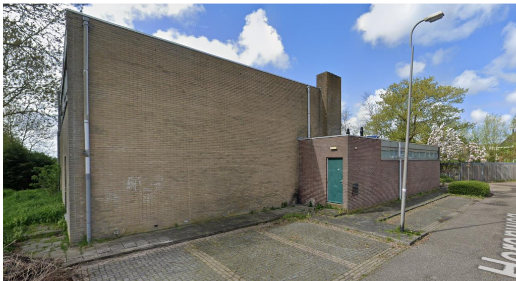
Afbeelding 4: Huidige situatie van het te slopen gebouw (sporthal) (bron: Google maps)
