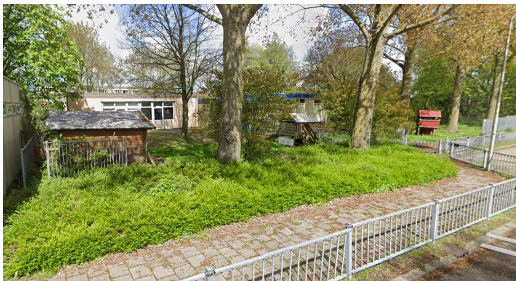
Afbeelding 2: Huidige situatie van het te slopen gebouw (kinderdagverblijf) (bron: Google maps)
