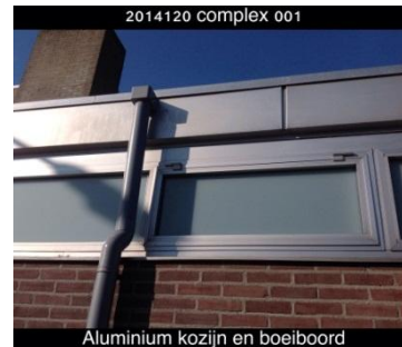
Foto 2: Aluminium kozijnen en boeiboorden.
