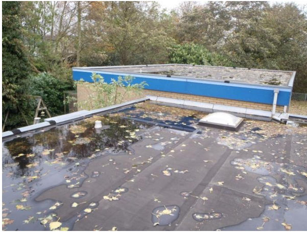
Foto 9: Dak, geen asbestverdachte materialen.
