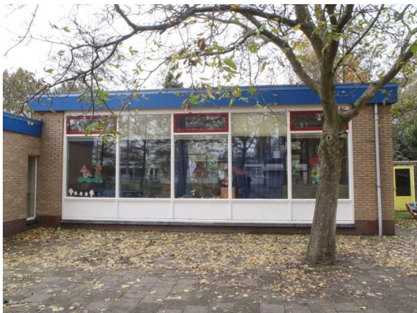
Foto 7: Kozijnen lokaal en raam directiekamer vervangen in 1999.
