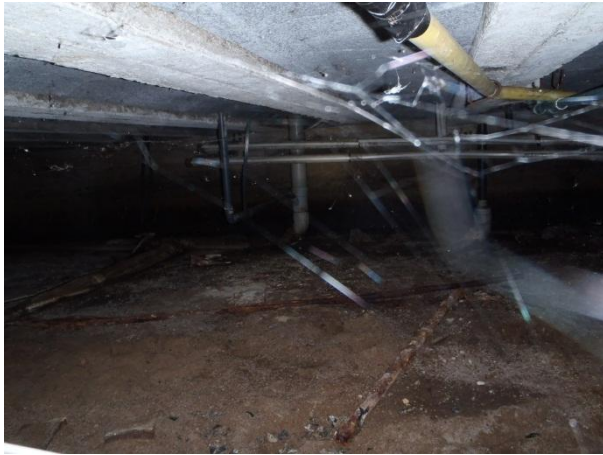
Foto 5: Kruipruimte, geen asbestverdachte materialen.
