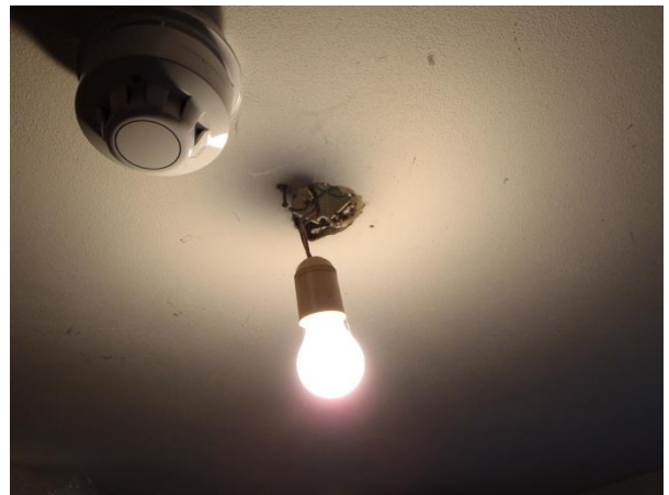
Foto 2: Plafondbeplating, niet asbestverdacht.
