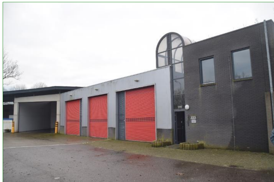
Bedrijfsgebouw (kantoor, garage, zoutopslag) rechts buitenbeeld de overkapping.
