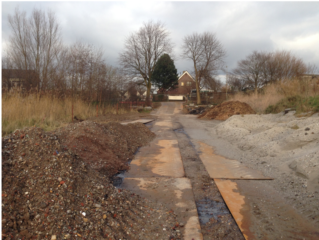
Figuur 3 Het braakliggend/verruigd terrein is thans ten deels in gebruik als opslag voor gww-bouwmaterialen zoals zand, puin, asfalt, houtsnippers, rijplaten en bebording (foto 2014).
