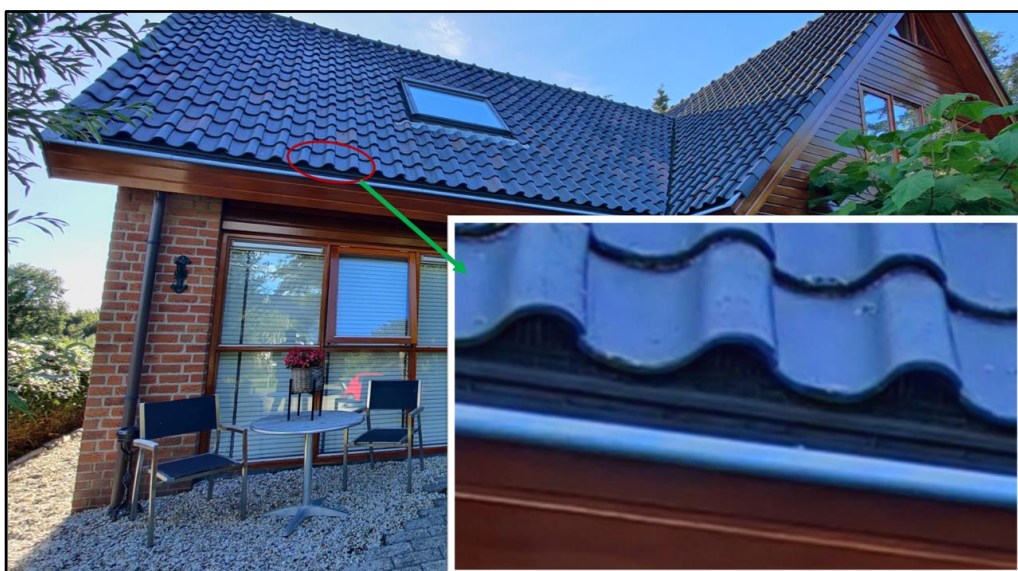
Figuur 2 De woning aan Voorweg 169 beschikt over vogelschroot waardoor er geen nestlocaties van huismus voorkomen.
