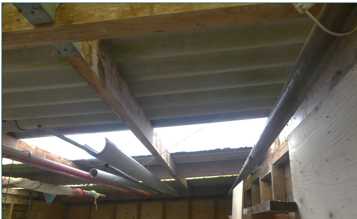
Figuur 2 De bebouwing bestaat uit houten gevels zonder spouw en een golfplaten dak zonder dakbeschoet.
