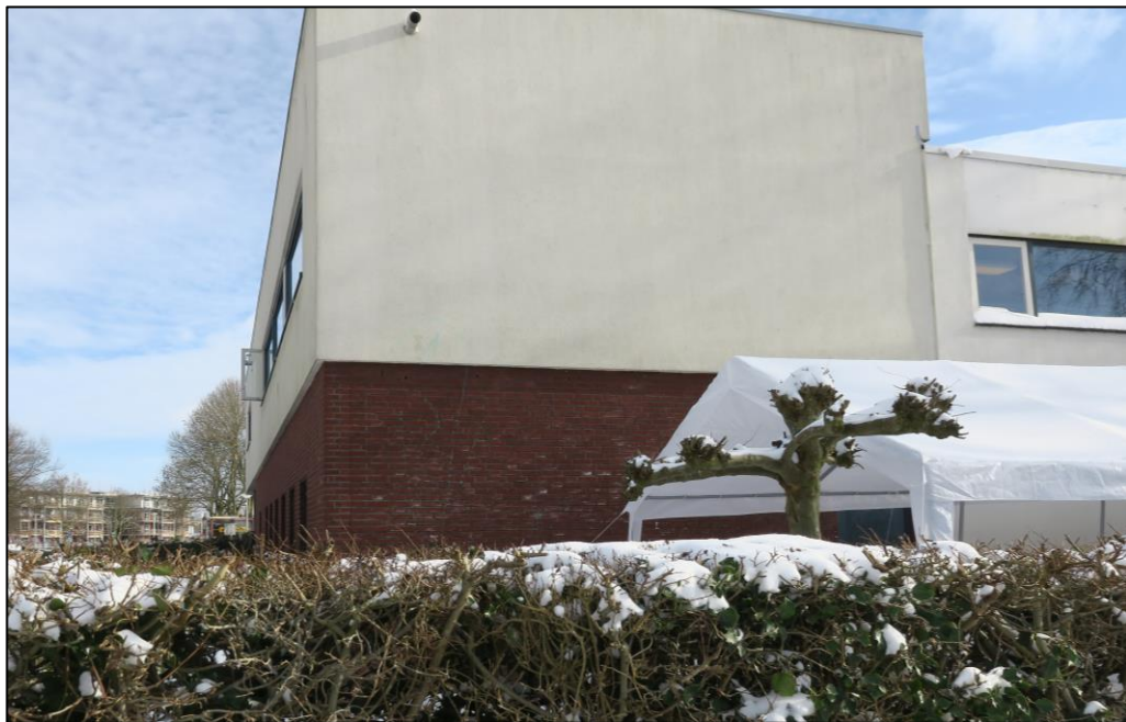
Figuur 6 Het schoolgebouw met gepleisterde en stenenmuren met daarin open stootvoegen.
