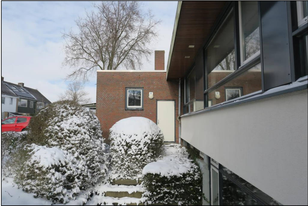
Figuur 3 De westgevel.
