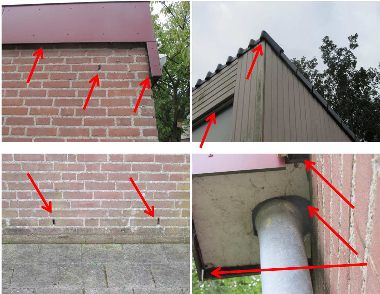
Figuur 3: geschikte inkruipopeningen voor vleermuizen: open stootvoegen, ruimtes achter boeidelen en regenpijpen, onder dakpannen en andere dakconstructies.
