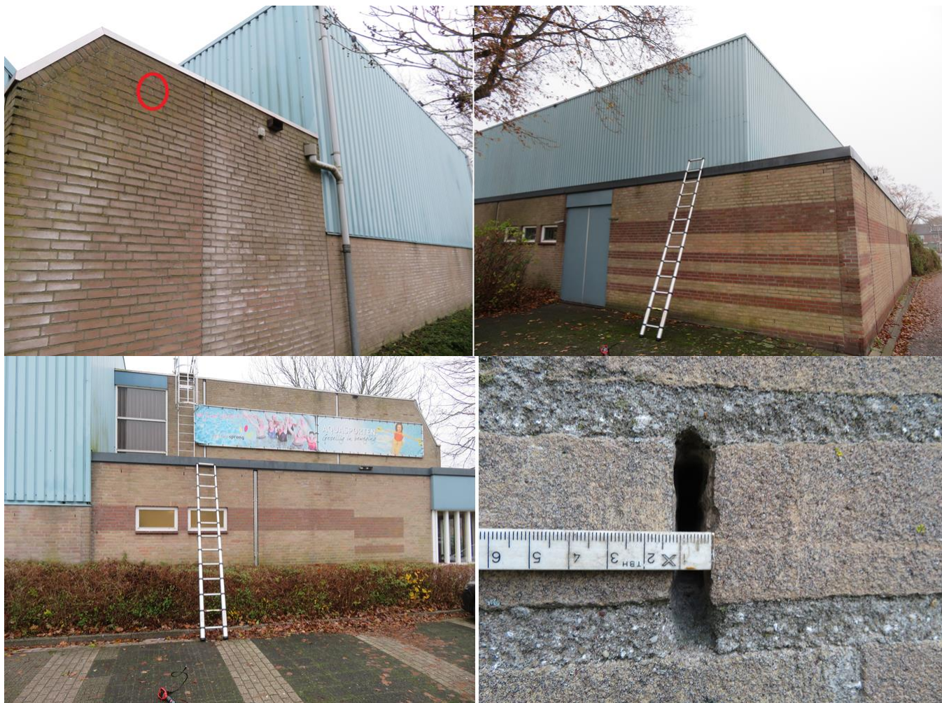
Afbeelding 9: Foto's van bijenbekjes, inspectiepunten en grootte van de open stootvoeg van de sporthal.
