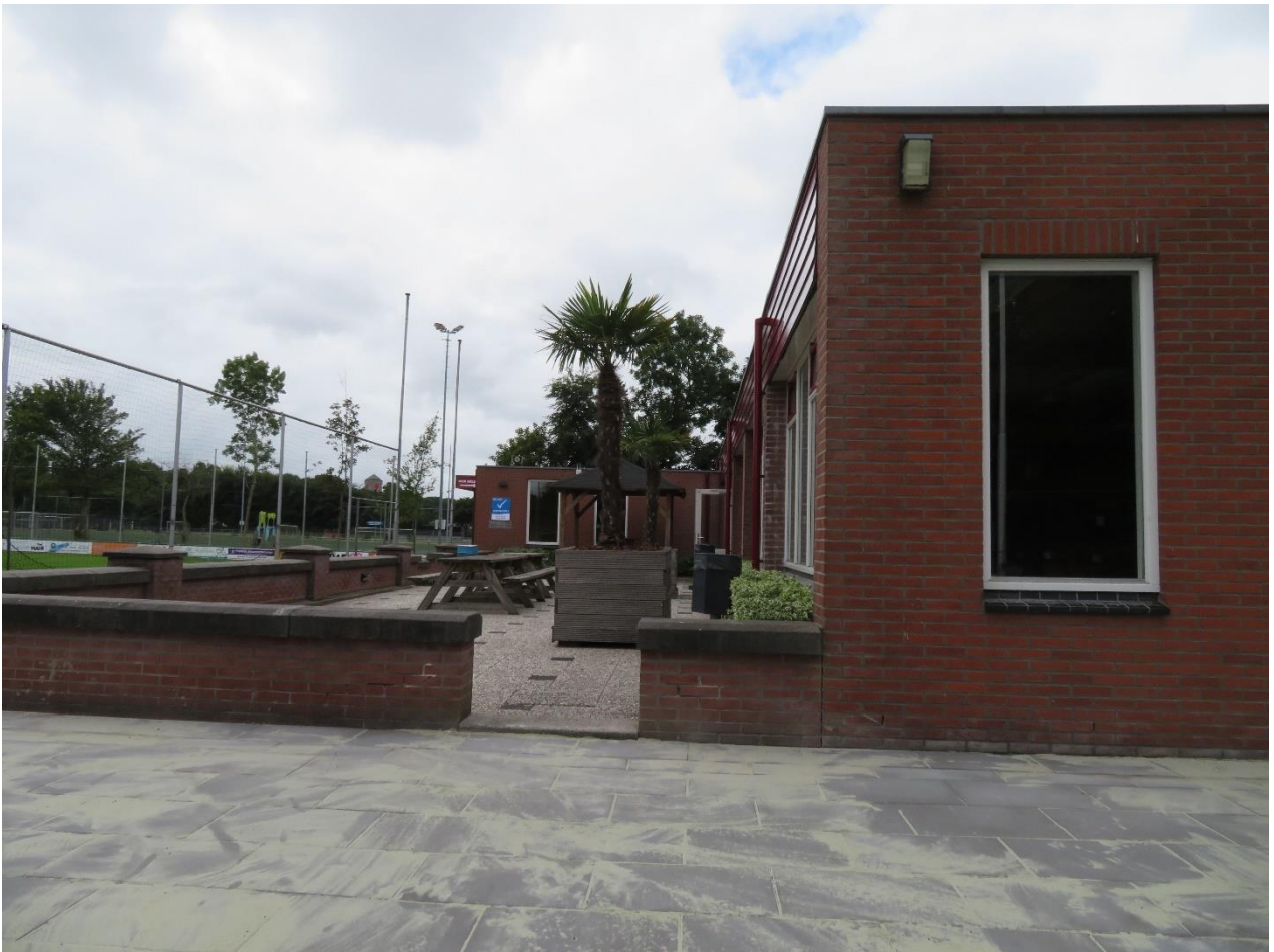
Achter de houten rabatdelen bij E.M.M. aan de voorzijde is geen ruimte voor vleermuizen aanwezig.
