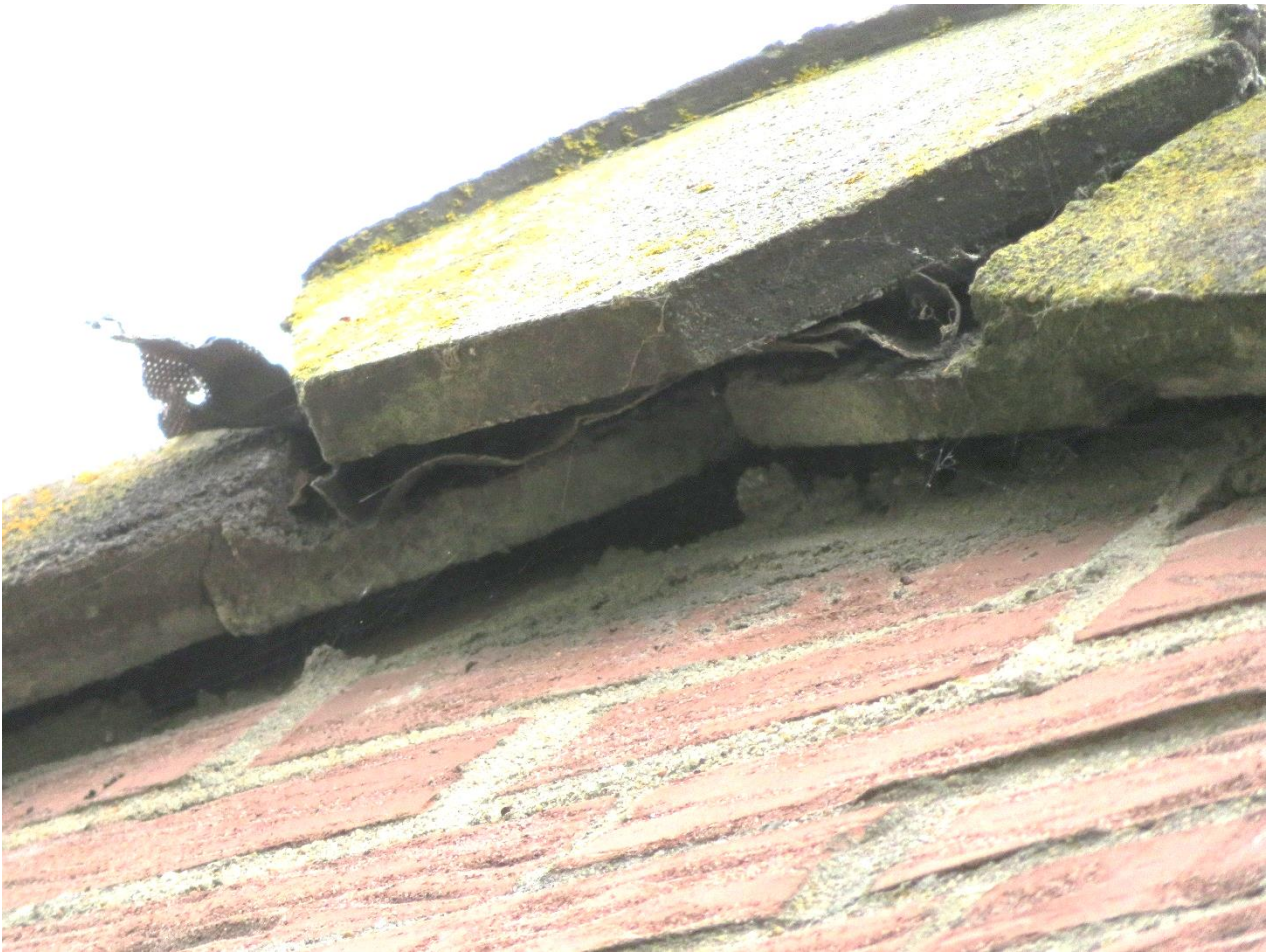
Nokpan Piet Mondriaanlaan 13-19. Hier is geen ruimte voor vleermuizen aanwezig. Bij de andere nokpannen is dit ook zo.
