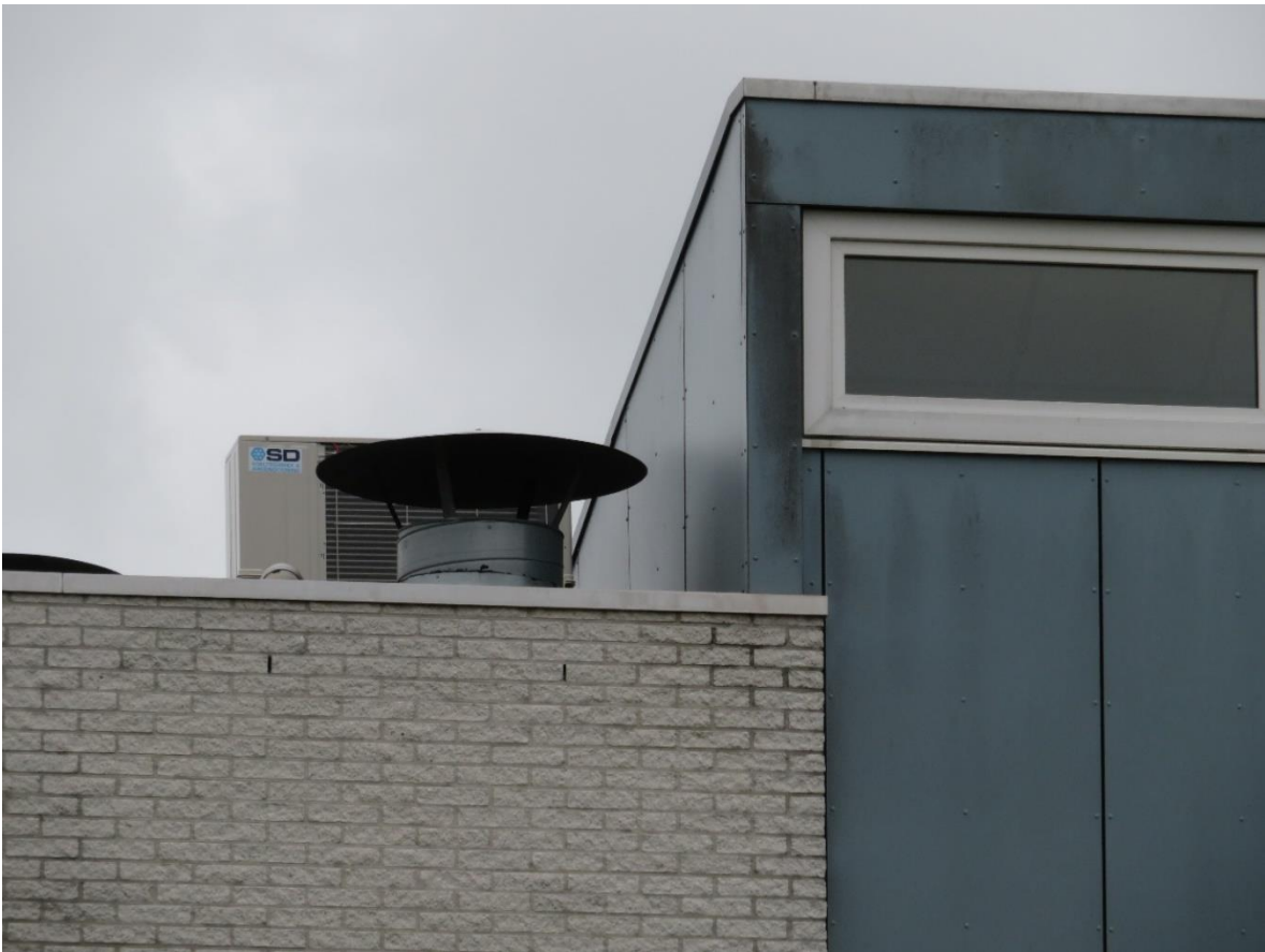
Aansluiting van de muur op de damwandbeplating van de sporthal. Hier zijn geen openingen aanwezig.
