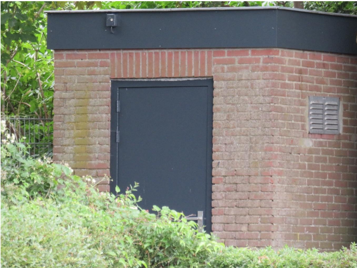
Elektriciteitshuisje in het plangebied. Achter de gevelbetimmering zijn geen openingen voor vleermuizen gevonden.
