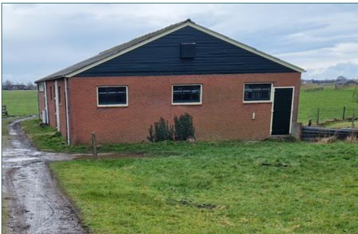
Figuur 2 De bebouwing bestaat uit een loods opgetrokken van bakstenen muren met een spouw en zadeldak van golfplaten zonder dakbeschot.
