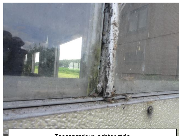
Toegangsdeur, achter strip
