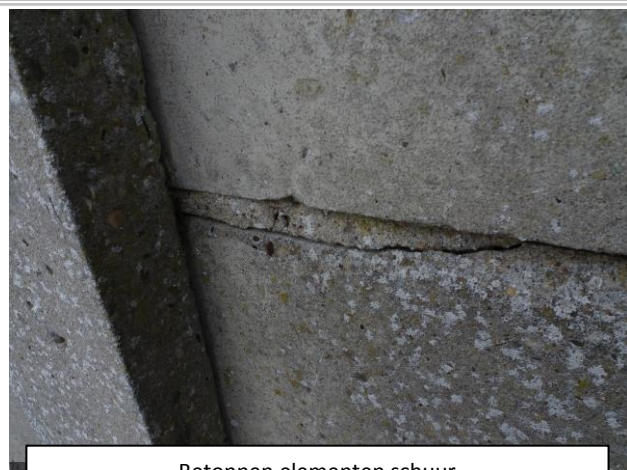
Betonnen elementen schuur
