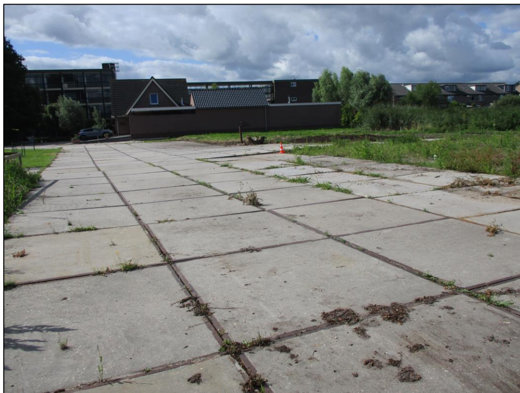
Figuur 4 De betonnen platen.
