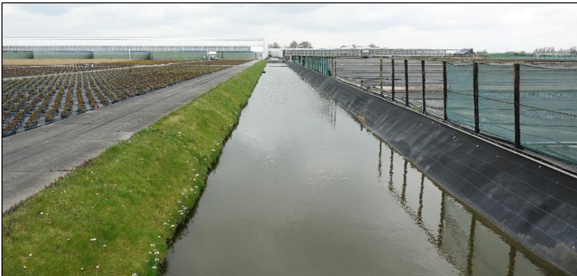
Figuur 5: Midden door het terrein loopt een kanaal met aan de ene zijde een verharde oever met worteldoek en aan de andere zijde een onverharde oever met kort gemaaid gras en enkele bloemen.
