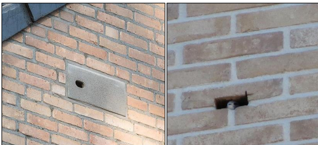
Figuur 4: InmetSELstenen zichtbaar (links) en onmetSELstenen (rechts) in de gevel verwerkt (bron: Vivarapro).
