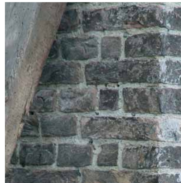
Hoek metselwerk noord-westgevel boerderij.
