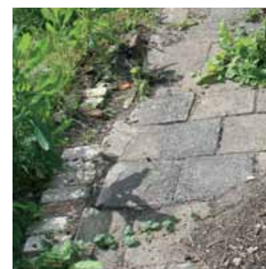
Fragment foto maaiveld ter plaatse van de oude schuur.
