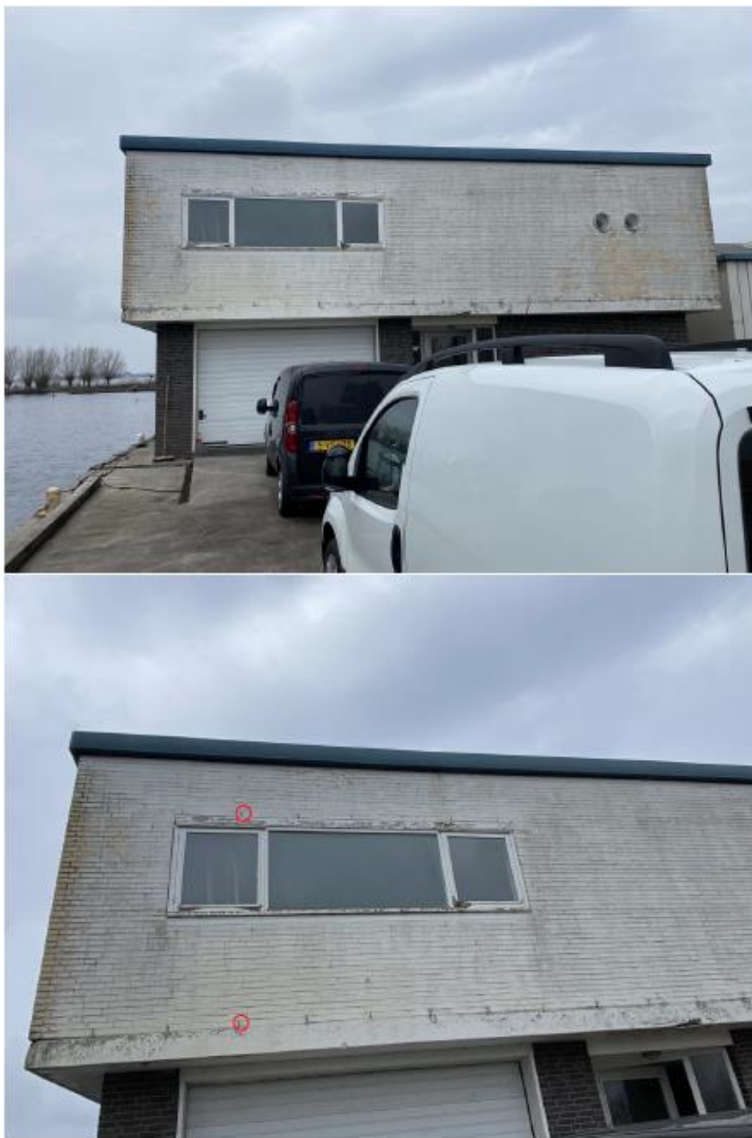
Figuur 6 Open stootvoegen
