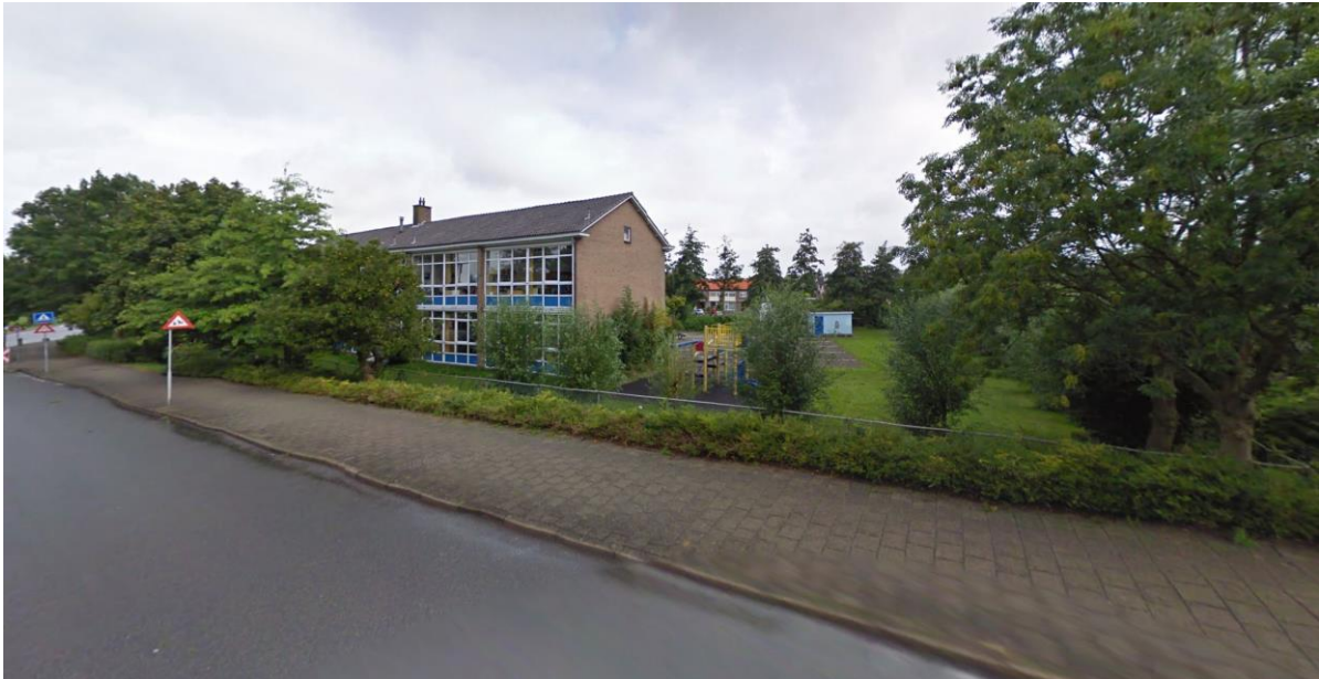
Afbeelding 2.1: bestaande situatie plangebied, zicht vanaf de Meerkreuk in noordwestelijke richting (bron: Google Streetview)
