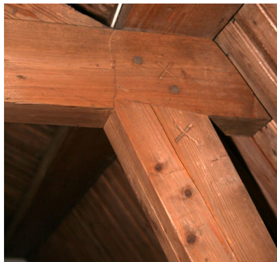
Afbeelding 17 (links) Trap naar zolder. Deur en trap in originele kleuren. Afbeelding 18 (boven) Telmerk op zolderbalken.
