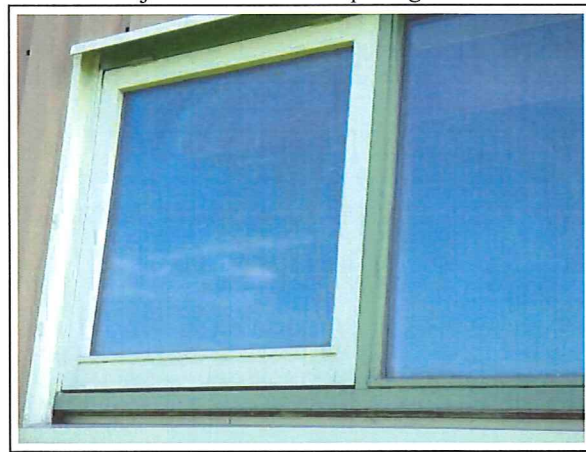
Foto 6: kozijnen loods zonder openingen
