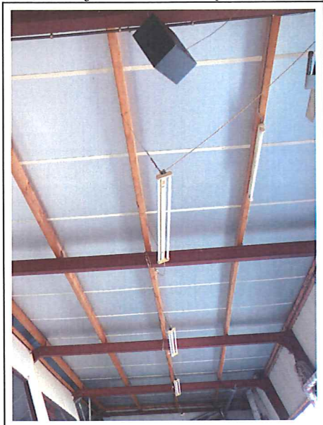
Foto 9: onderzijde dak lood met prefab isolatieplaten
