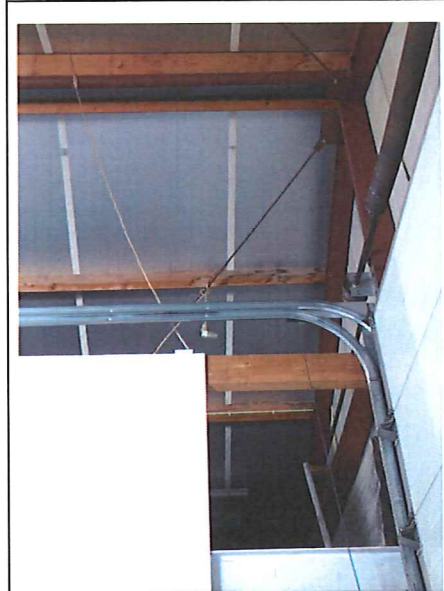
Foto 10: onderzijde dak lood met prefab isolatieplaten
