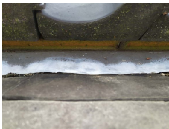
Figuur 12 Overgang van plat dak naar dakpannen
