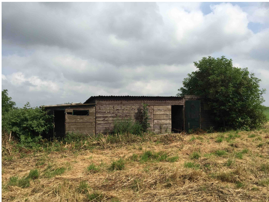
Figuur 4 Ten westen van de planlocatie ligt een kleine schuur (25 m 2 ) die wordt gesloopt wordt ten behoeve van de nieuwe loods.
