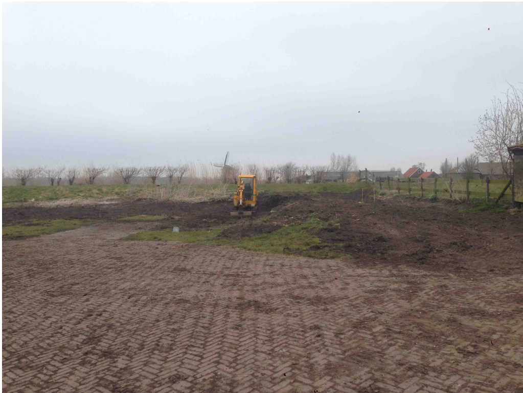
Figuur 3 De beoogde ontwikkellocatie ten behoeve van de nieuwe schuur is deels verhard en deels in gericht als grasland.
