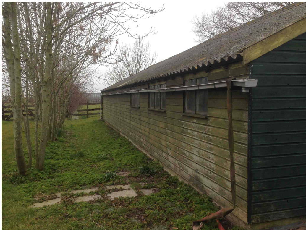
Figuur 2 De kanalen van de golfplaten op het dak van de schuur zijn aan weerszijden open waardoor er sprake is van een continue luchtstroom.
