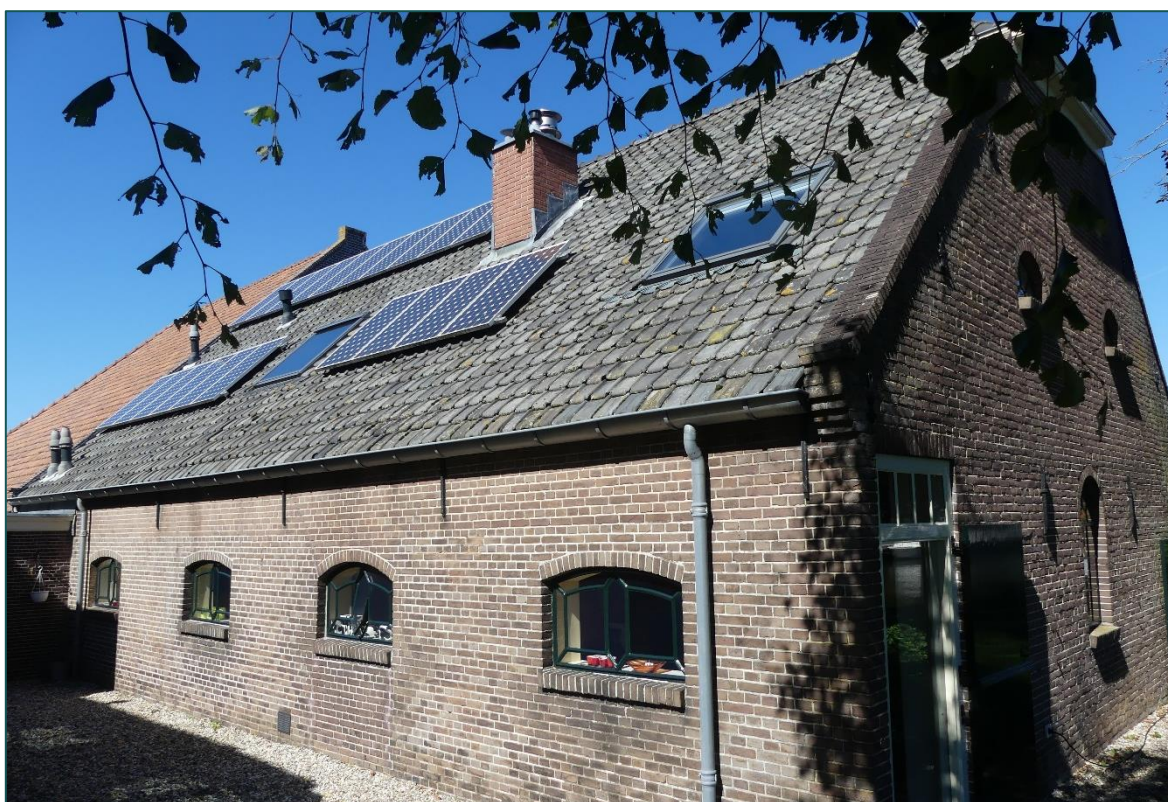
Figuur 4 Een van de schuren (5) welke zal worden verbouwd tot woning.
