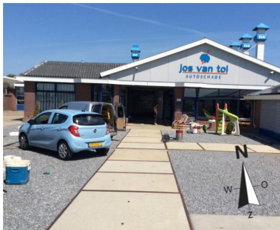
Foto 1: Zijaanzicht van de voorzijde van de onderzoekslocatie
