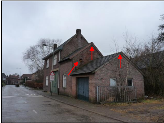
Figuur 7. Open stootvoegen
